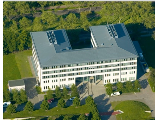
UFZ-Gebäude in Halle in der Theodor-Lieser-Straße 4
