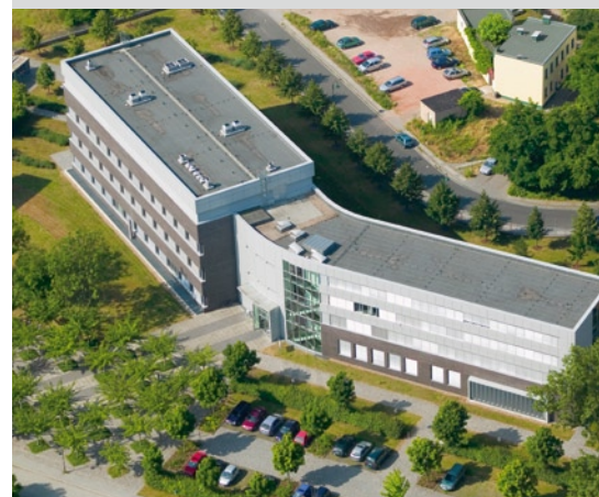
UFZ-Gebäude in Magdeburg in der Brückstraße 3a
